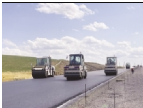
Pokládka asfaltových vrstev na 3. úseku (Milín – Lety).
