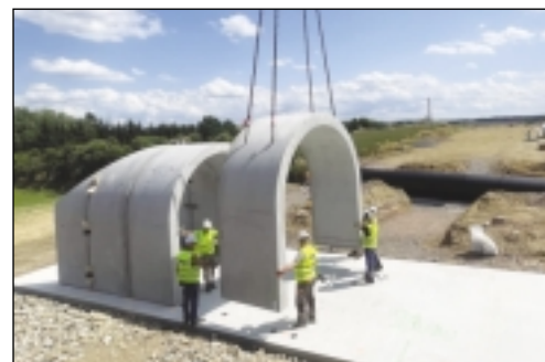
Stavba podchodu pro pěší na 3. úseku (Milín – Lety).
