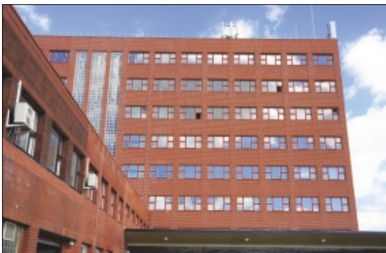
Kompletní rekonstrukce výškové části budovy na pardubickém hlavním nádraží je hotová.
